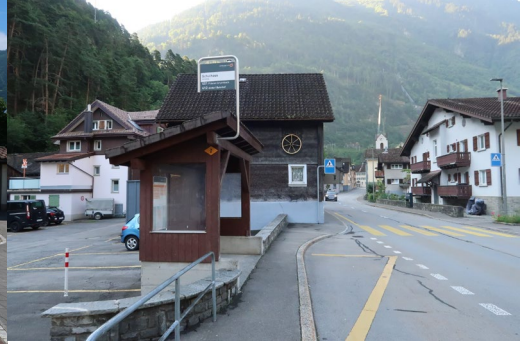
Abbildung 13: Beispiel einer Bushaltestelle mit schmal ausgestaltetem Warteraum (Aufnahme in Amsteg)
