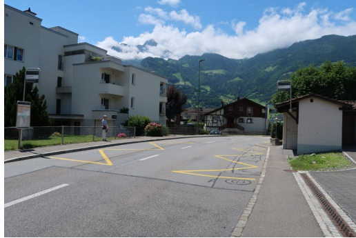
Abbildung 12: Beispiel einer Bushaltestelle mit fehlender punktueller Querungsmöglichkeit (Aufnahme in Schattdorf)
