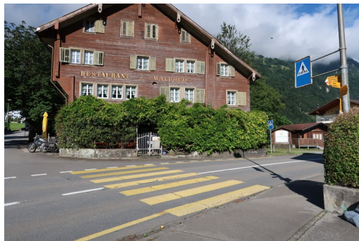
Abbildung 10: Beispiel eines überfahrbaren Warteraums (Aufnahme in Seedorf)
