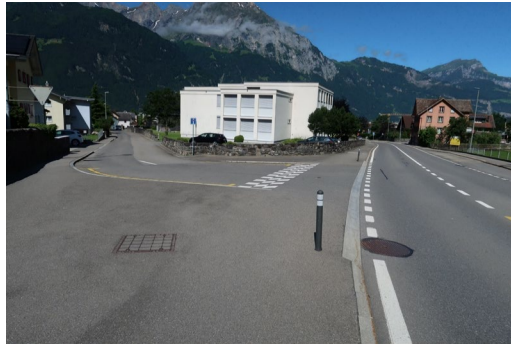
Abbildung 16: Beispiel einer Trottoirüberfahrt mit Pollern zur Verhinderung des Streifens (Aufnahme in Bürglen)
