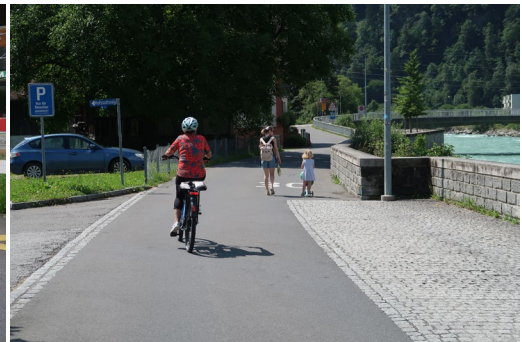
Abbildung 5: Beispiel einer fehlenden Längsverbindung (Aufnahme in Erstfeld)
