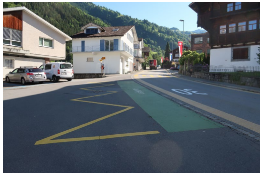
Abbildung 14: Beispiel eines baulich nicht abgetrennten Warteraums (Aufnahme in Bürglen)
