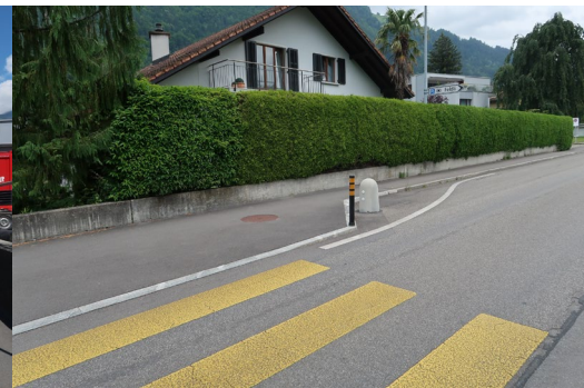
Abbildung 19: Beispiel eines Trottoirnasen (Aufnahme in Altdorf)
