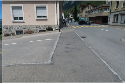
Abbildung 16: Beispiel einer Trottoirüberfahrt mit Pollern zur Verhinderung des Streifens (Aufnahme in Bürglen)
