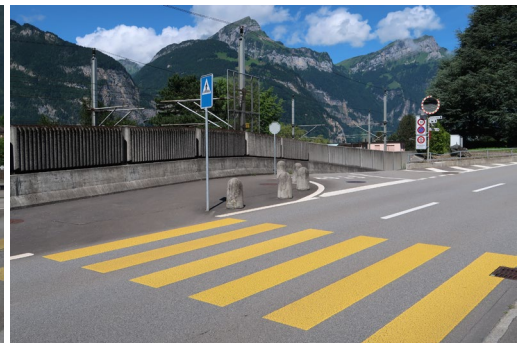
Abbildung 9: Beispiel eines mangelhaften Warteraums aufgrund fehlendem Randabschluss (Aufnahme in Flüelen)
