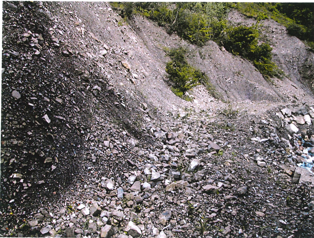
Abbildung 4 Kritischer Hangabschnitt (Blockverbau empfohlen)
