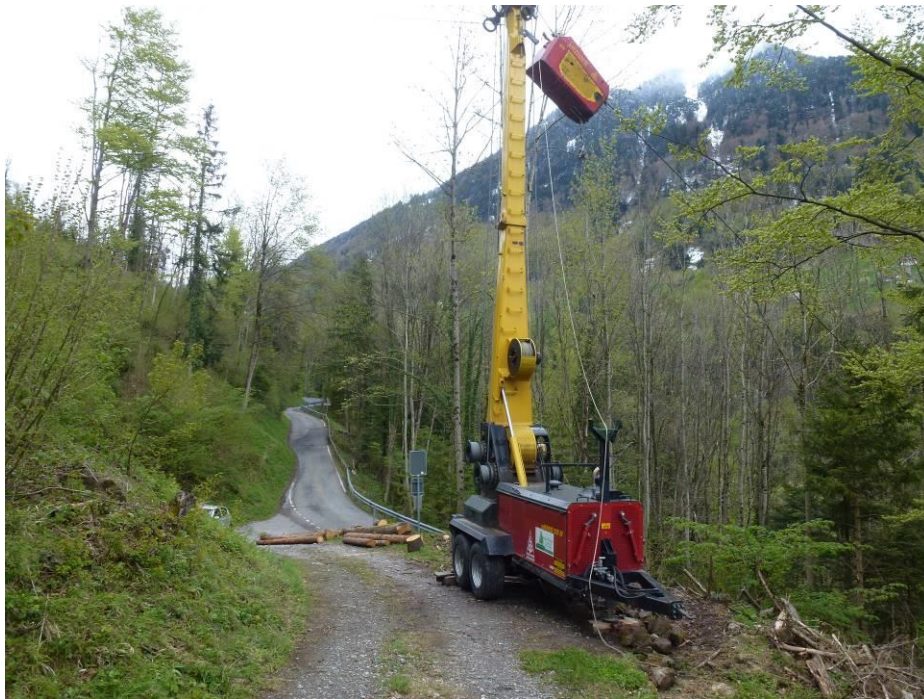
Foto 1: Fertig installierter Mobilseilkran oberhalb der Riemenstaldnerstrasse für den Transport des Holzes hinunter zur Rutschung Rüti (oeko-b, 26.04.2016).
