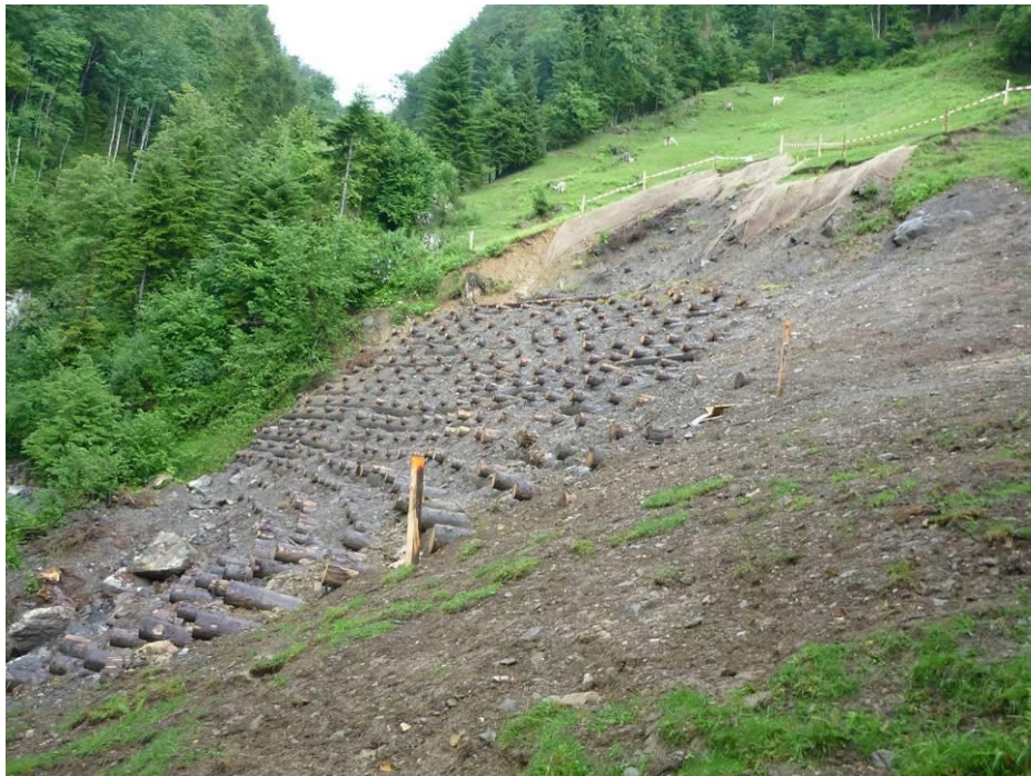
Foto 28: Fertig erstellter Holzkasten nach Abschluss aller Arbeiten (Aft Kt. UR, 14.07.2016).
