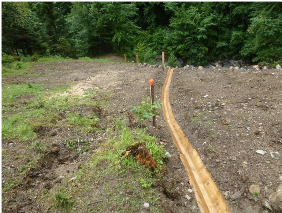
Foto 26: Eingebauter Holzkännel und Pfosten, welche den Übergang Wiesland / Wald markieren (oeko-b, 12.07.2016).
