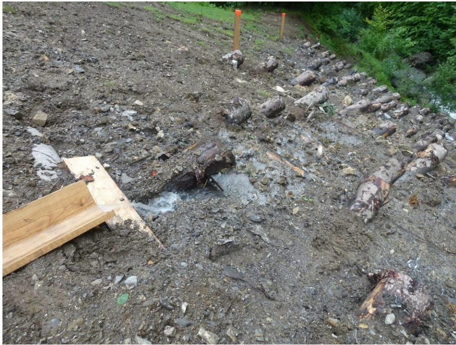
Foto 27: Ableitung des Wassers über den Holzkasten (oeko-b, 12.07.2016).
