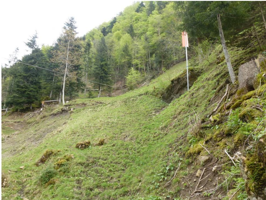
Foto 2: Verankertes Transportseil des Mobilseilkrans bei der Rutschung Rüti (oeko-b, 26.04.2016).
