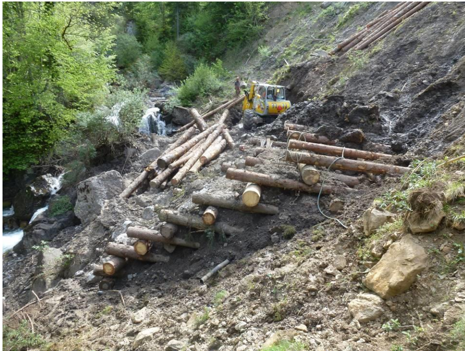
Foto 7: Fortschreitende Verbauarbeiten in Richtung talaufwärts (oeko-b, 09.05.2016).
