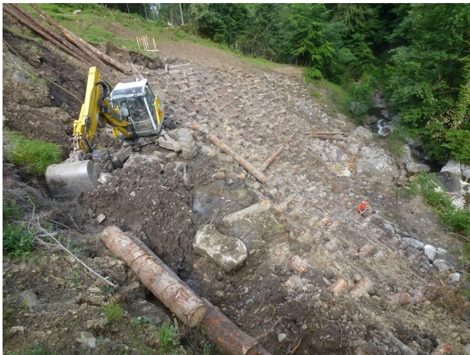
Foto 20: Abschlussarbeiten und Verbau der letzten Holzstämmen im obersten Bereich des Holzkastens (oeko-b, 05.07.2016).
