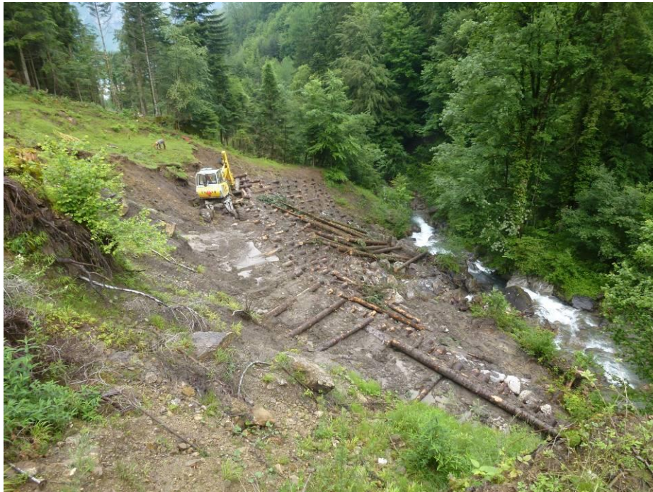
Foto 18: Baustellenübersicht mit fortgeschrittenen Arbeiten am Holzkasten (oeko-b, 20.06.2016).
