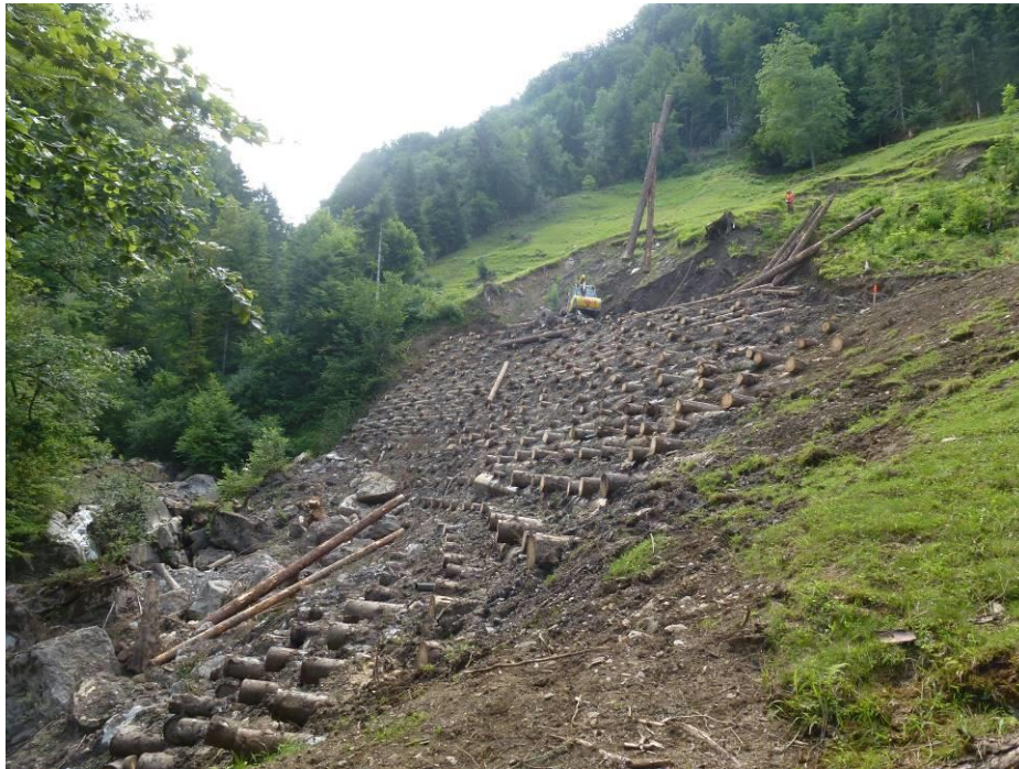
Foto 21: Abschlussarbeiten und Seilen / Verbau der letzten Holzstämme im obersten Bereich des Holzkastens (oeko-b, 05.07.2016).
