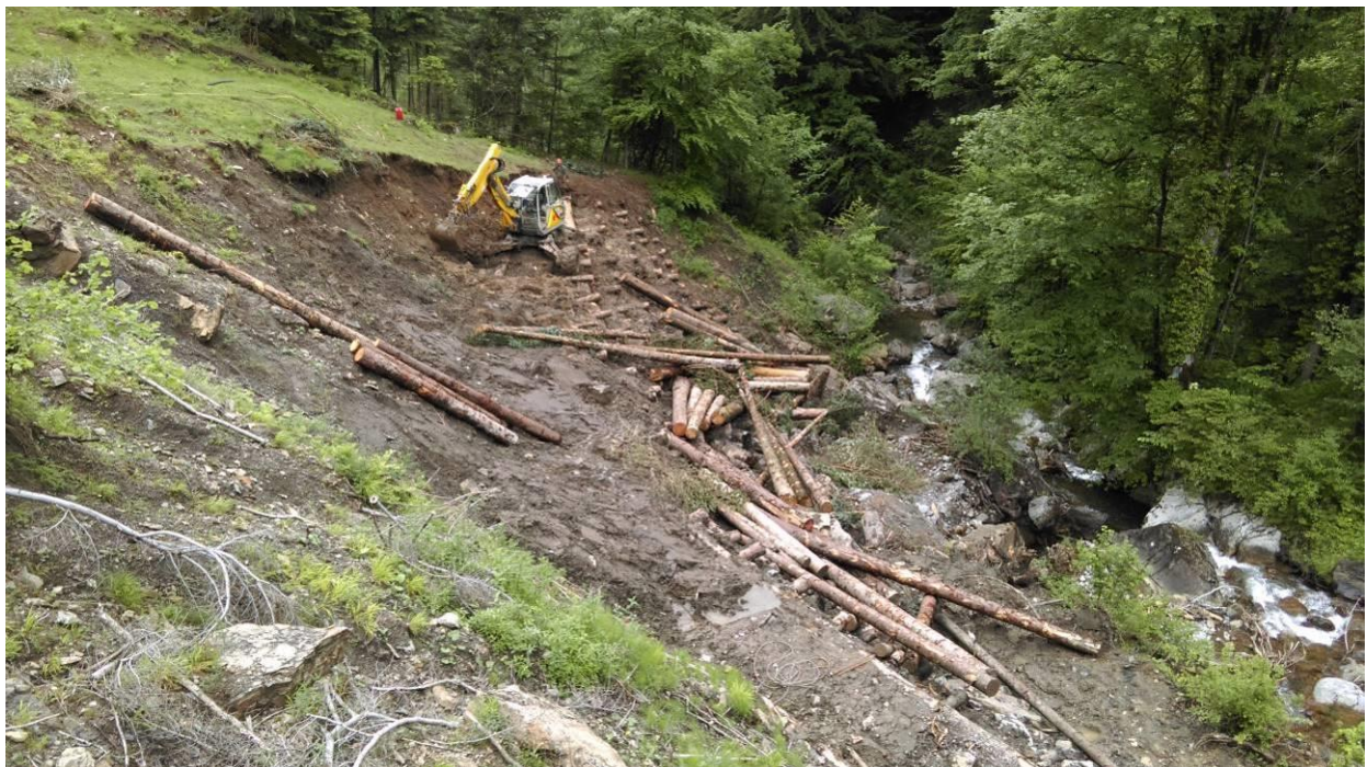
Foto 16: Fertigstellungsarbeiten am unteren Ende des Holzkastens (oeko-b, 03.06.2016).
