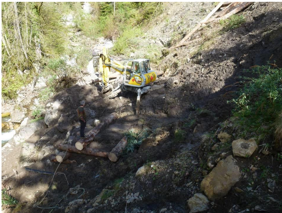
Foto 4: Abgeschlossener Einbau eines ersten Elementes mit 4 m Länge (oeko-b, 28.04.2016).
