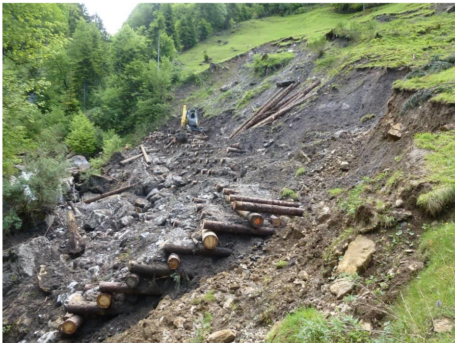
Foto 14: Baustellenübersicht mit fortgeschrittenen Arbeiten am Holzkasten (oeko-b, 20.05.2016).
