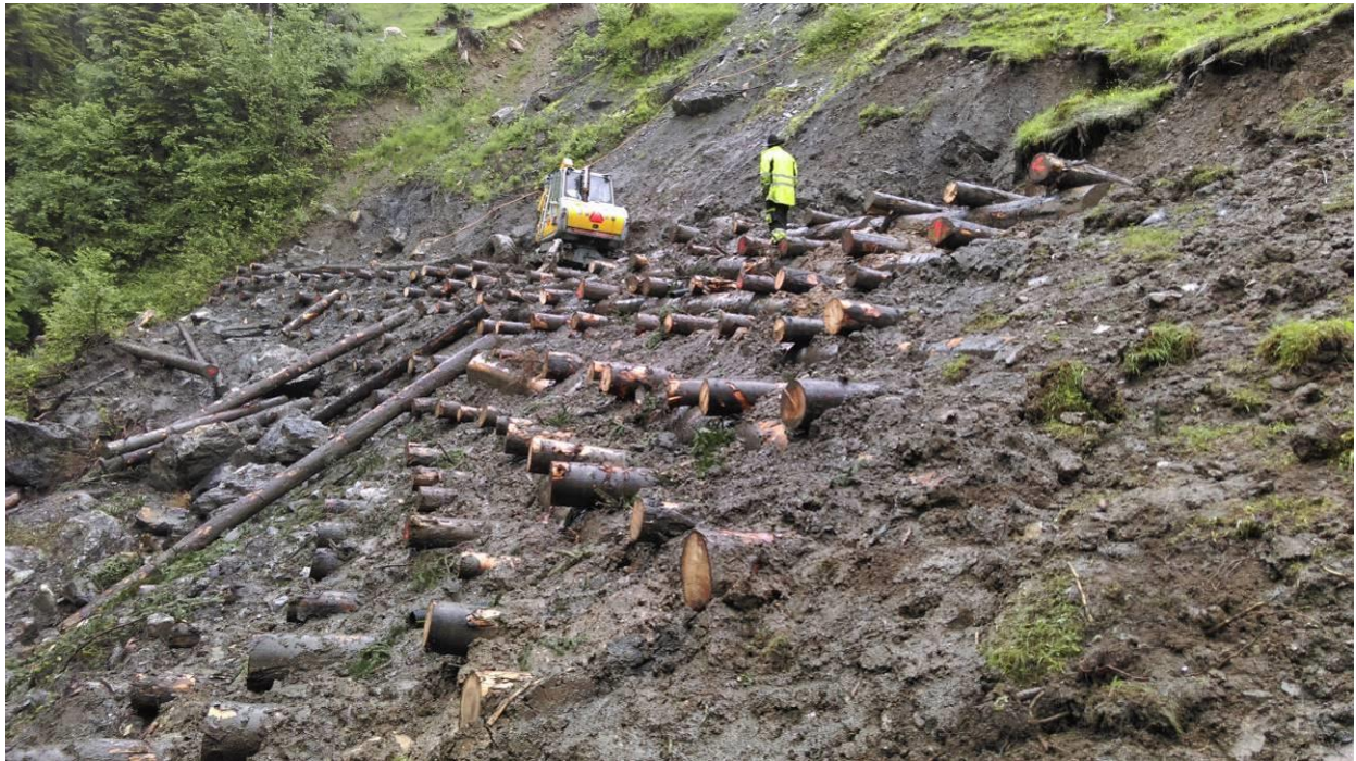
Foto 17: Baustellenübersicht mit fortgeschrittenen Arbeiten am Holzkasten (oeko-b, 09.06.2016).
