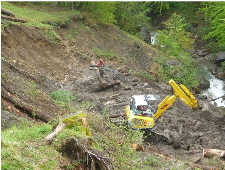
Foto 6: Arbeiten am 2 Element des Holzkastens (03.05.2016).
