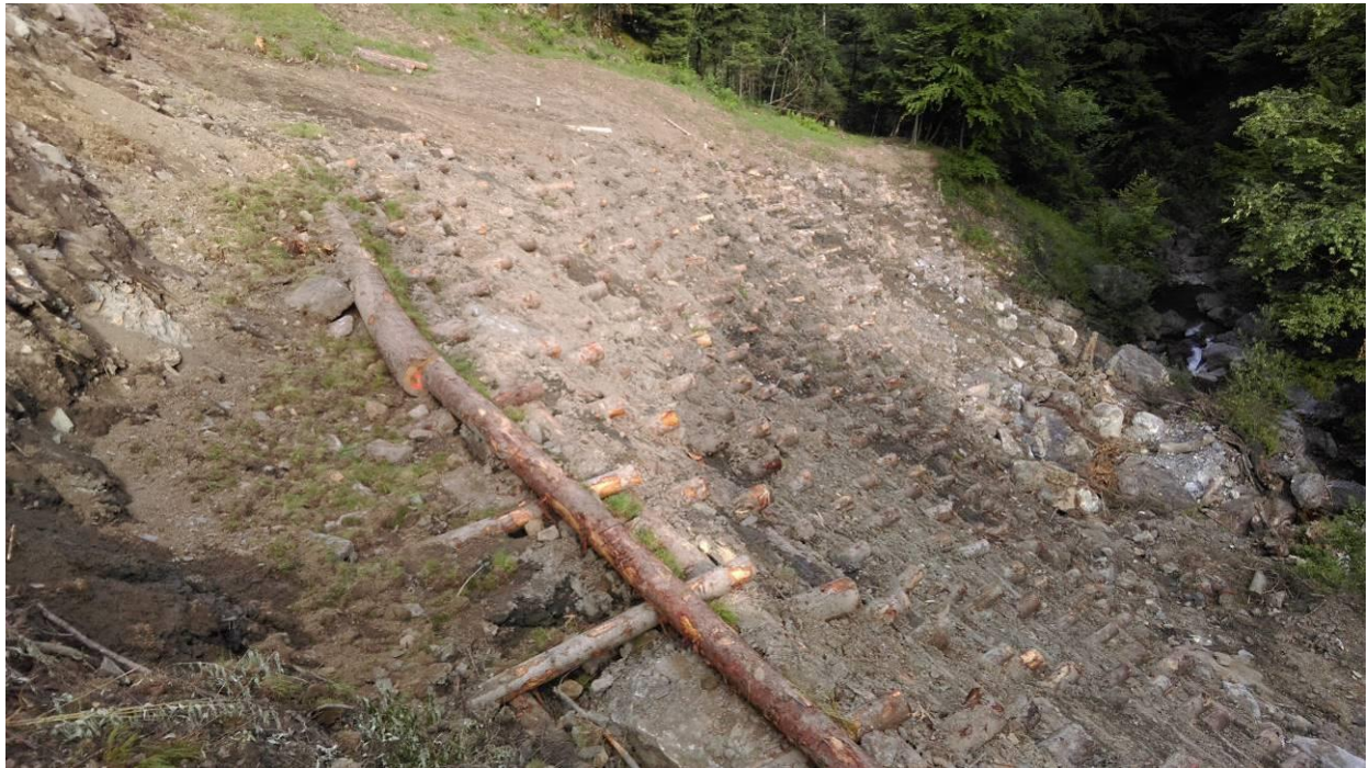
Foto 23: Abgeschlossene Arbeiten am Holzkasten nach Einbau der letzten Holzstämmen (oeko-b, 08.07.2016).
