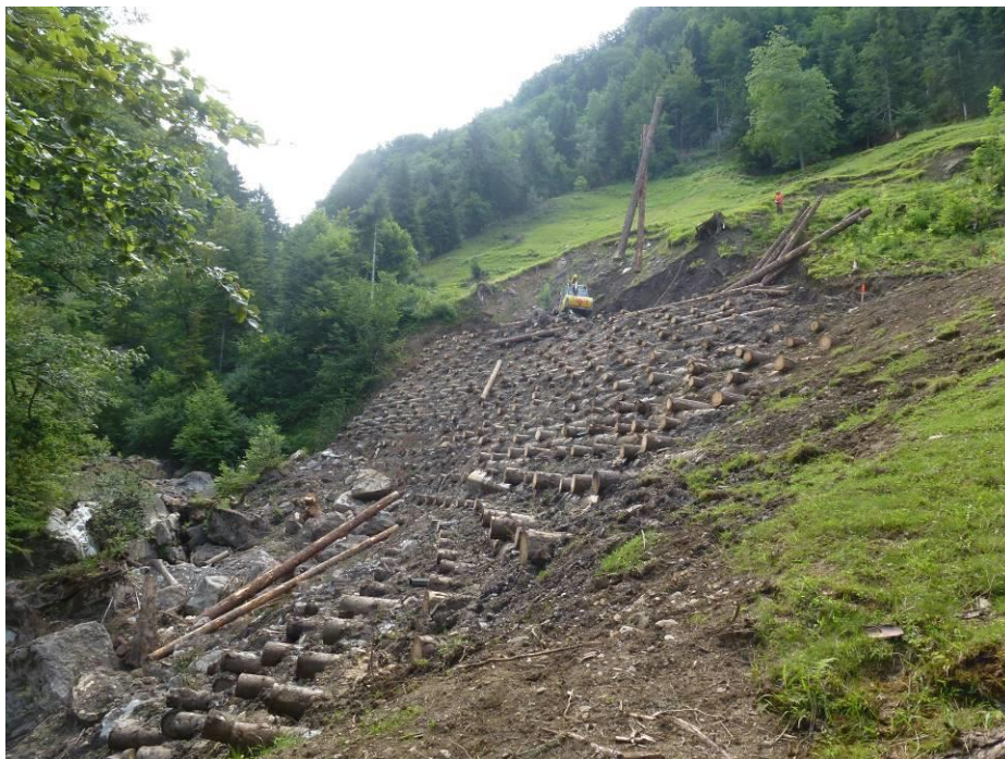
Foto 22: Abschlussarbeiten und Seilen / Verbau der letzten Holzstämme im obersten Bereich des Holzkastens (oeko-b, 05.07.2016).
