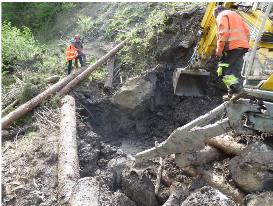
Foto 8: Aushubarbeiten mit Grossblock am hinteren Grubenrand (oeko-b, 09.05.2016).
