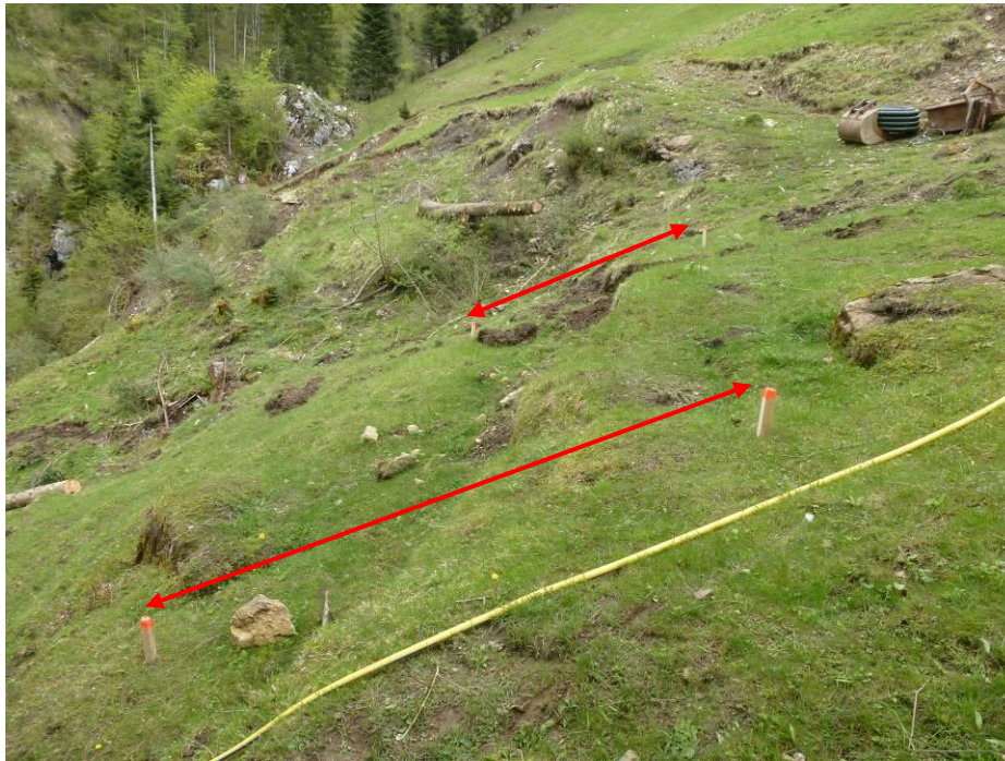
Foto 3: Einfache Überwachungseinrichtung zur Erkennung allfälliger Hangbewegungen mittels Messung der Distanz (roter Pfeil) im Bereich der Anrisskante (oeko-b, 26.04.2016).
