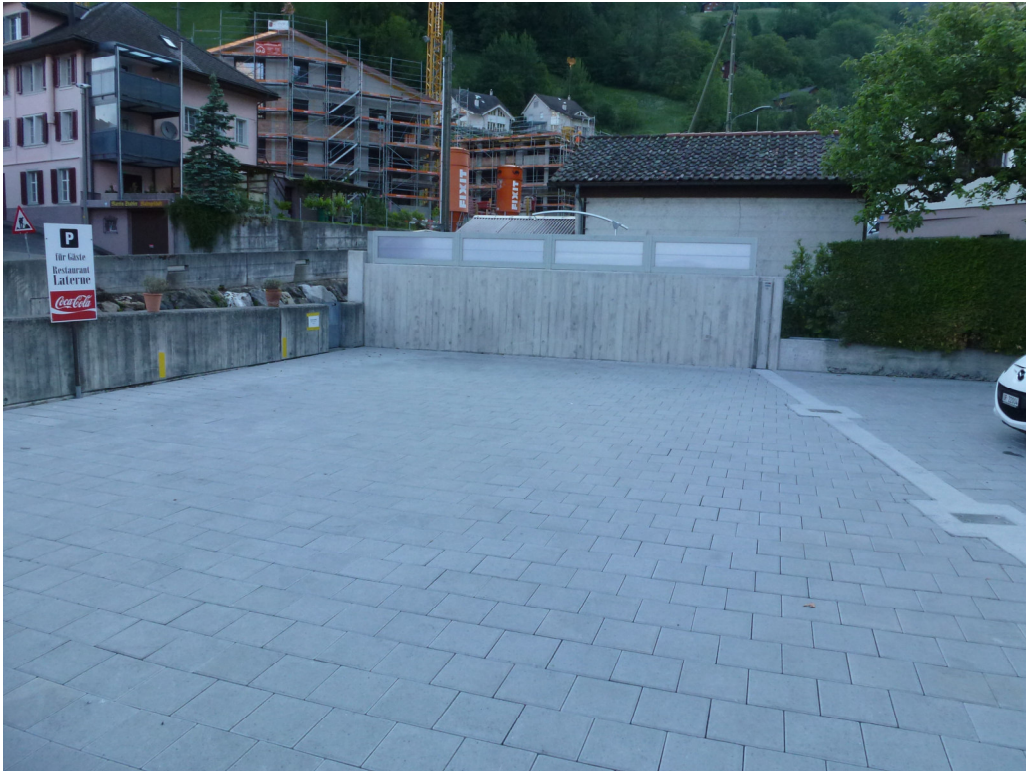
Abb. 5: Dammbalkenverschluss bei Rest. Laterne mit fixen Betonmauer 18.05.2018
