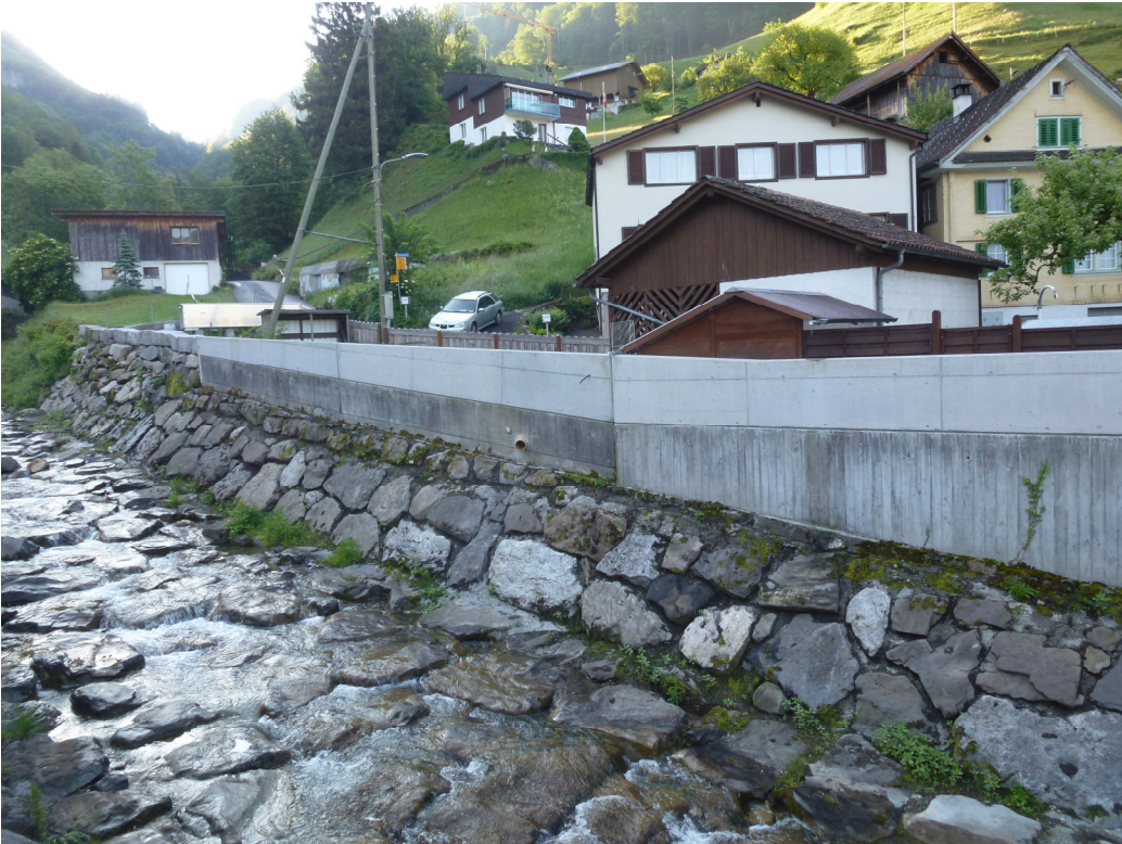
Abb. 7: fixe Betonmuer auf bestehende Betonmuer entlang Riemenstraldnerbach 18.05.2020
