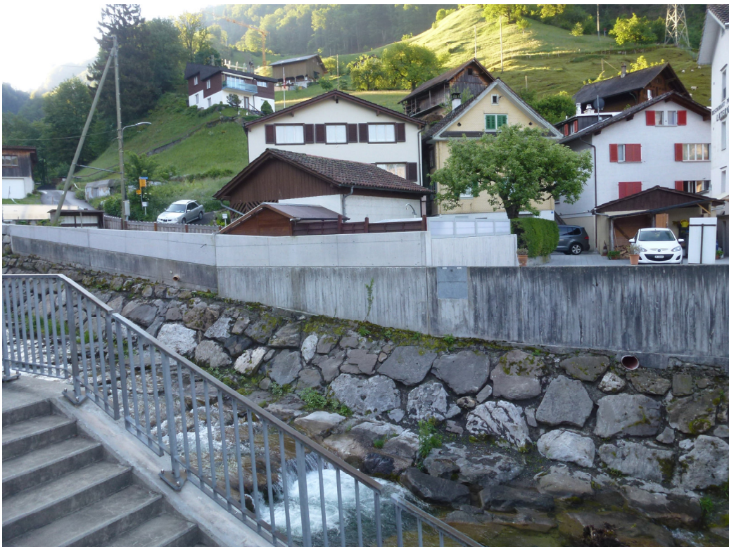
Abb. 6: fixe Betonmauer auf bestehende Betonmauer entlang Riemenstraldnerbach 18.05.2020
