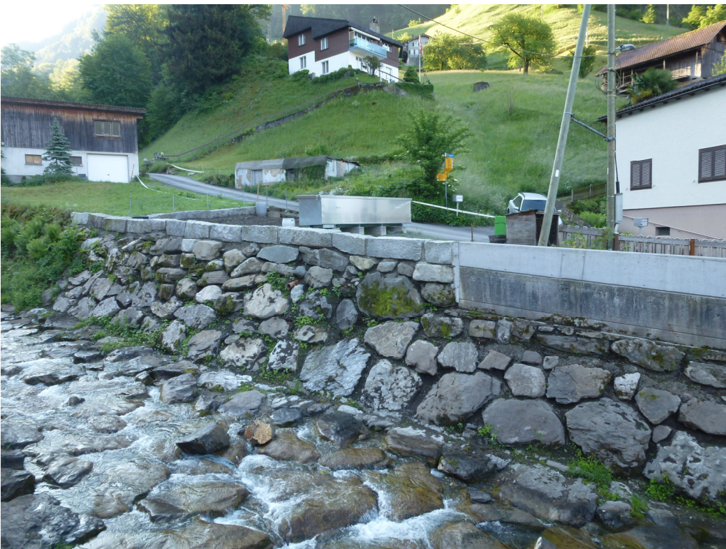
Abb. 7: fixe Betonmuer auf bestehende Betonmuer entlang Riemenstraldnerbach 18.05.2020
