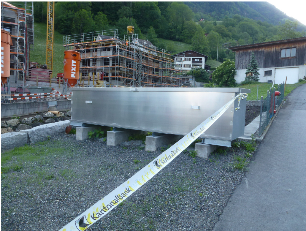
Abb. 10: Dammbalken-depot für Dammbalkenverschluss bei Rest. Laterne 18.05.2020
