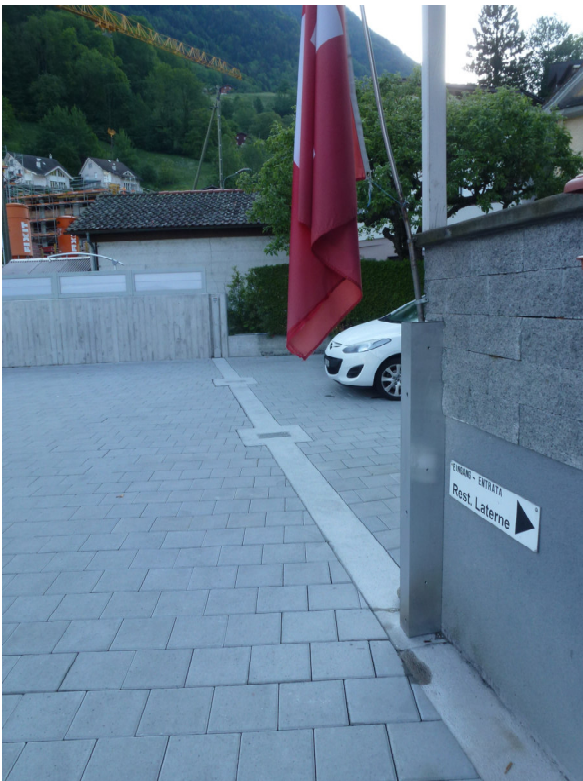
Abb. 4: Dammbalkenverschluss bei Rest. Laterne mit fixen Betonmauer 18.05.2018
