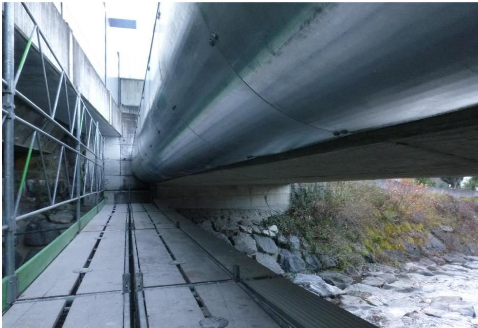
**Foto 8:** Ansicht von unten auf fertig montiertes Schutzblech mit ungleichmässig verlaufender Brückenunterkante (oeko-b, 06.12.2016).
