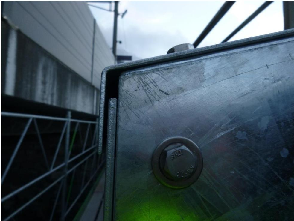
**Foto 9:** Seitliche Ansicht auf montiertes Schutzblech mit Übergang vom Schutzblech zum Abdeckblech (oeko-b, 06.12.2016).
