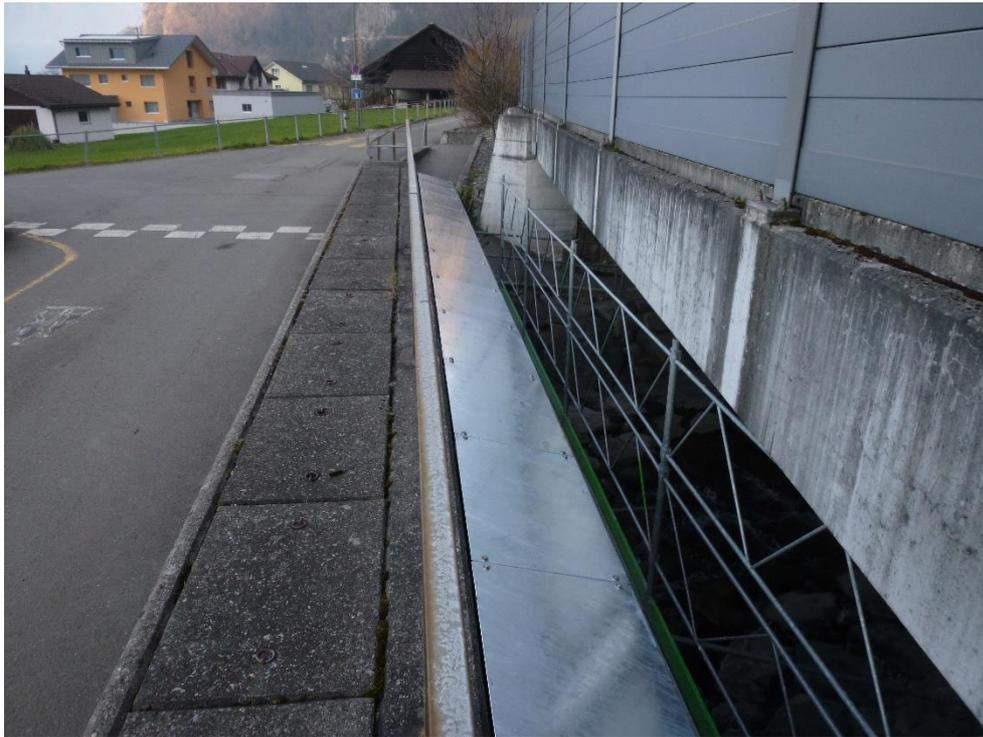
**Foto 5:** Ansicht von oben auf fertig montiertes Schutzblech nach Abschluss der Arbeiten (oeko-b, 06.12.2016).
