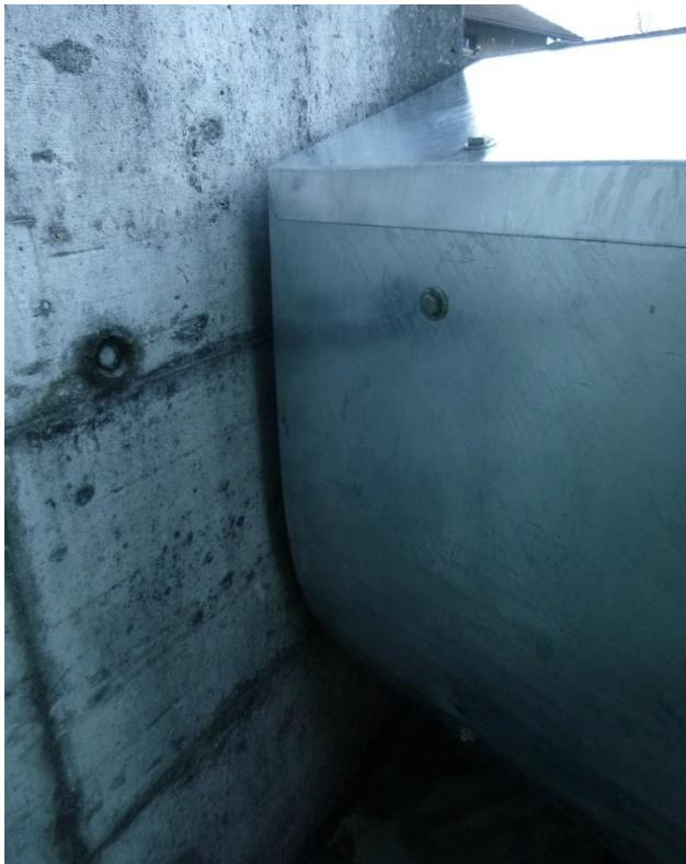
**Foto 6:** Anschluss des Schutzblechs an die linksseitige Ufermauer nach Abschluss der Arbeiten (oeko-b, 06.12.2016).
