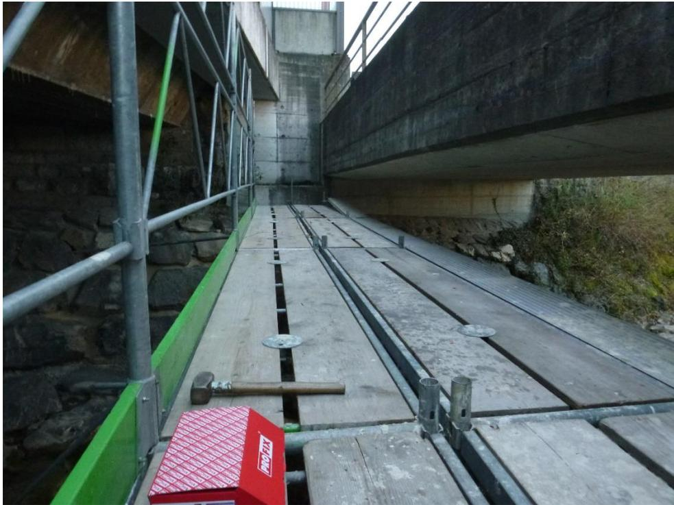
**Foto 3:** Baugerüst im Riemenstaldnerbach vor Beginn der Schutzblechmontage (oeko-b, 05.12.2016).
