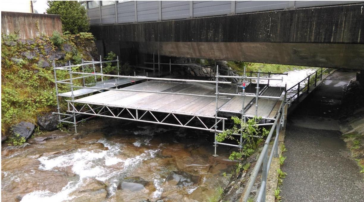
**Foto 3:** Fertig montiertes Baugerüst im Riemenstaldnerbach vor Beginn der Schutzblechmontage (oeko-b, 12.05.2016).
