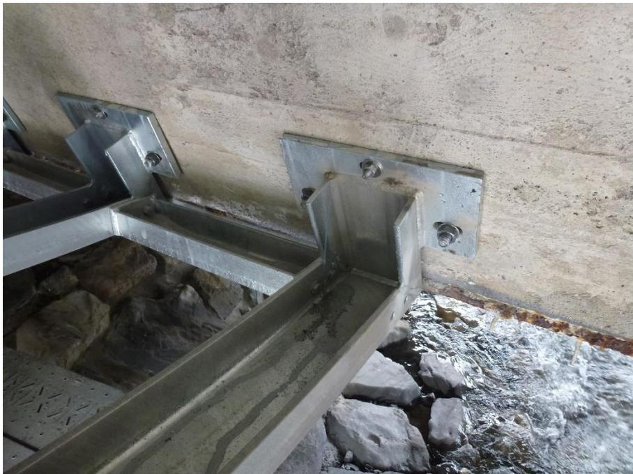
**Foto 6:** Untere Verschraubung der montierten Unterkonstruktion auf der orographisch linken Seite der SBB-Brücke (oeko-b, 17.05.2016).
