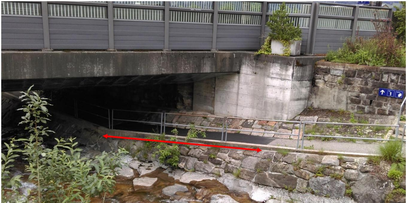
**Foto 12:** Abgesenkter Wegabschnitt (roter Pfeil) mit neuem Belag nach Abschluss der Arbeiten (oeko-b, 03.06.2016).
