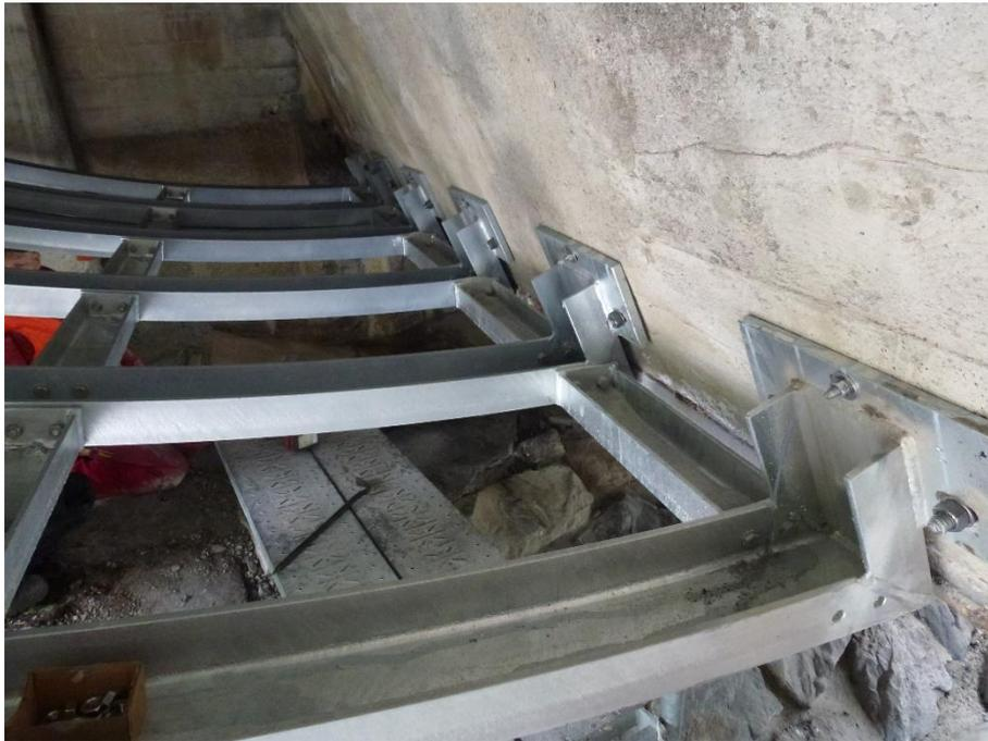
**Foto 5:** Fertig montierte Unterkonstruktion auf der orographisch linken Seite der SBB-Brücke (oeko-b, 17.05.2016).
