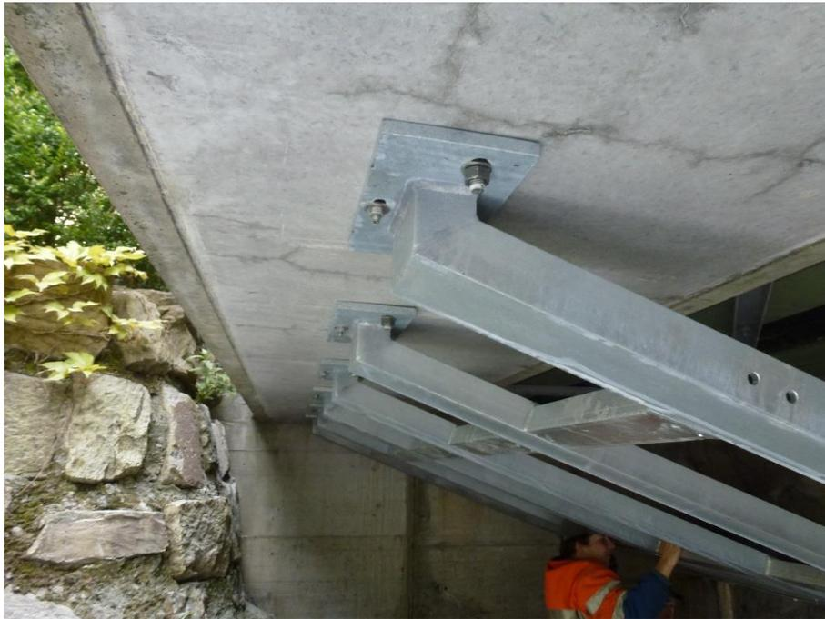
**Foto 7:** Fertig montierte Unterkonstruktion auf der orographisch linken Seite der SBB-Brücke (oeko-b, 17.05.2016).
