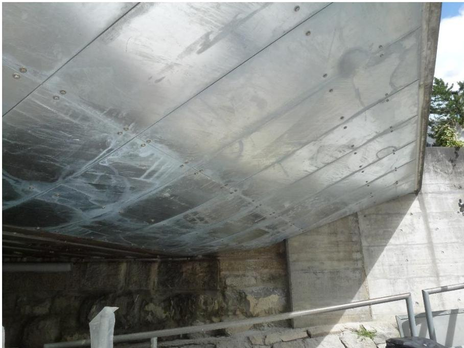
**Foto 10:** Fertig montiertes Schutzblech nach Abschluss der Arbeiten (oeko-b, 20.05.2016).
