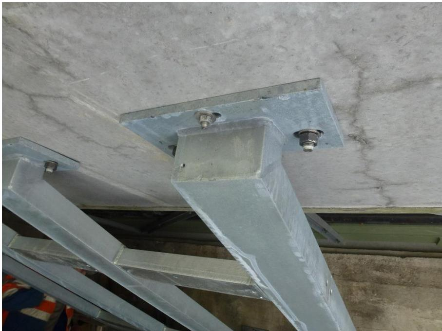
**Foto 8:** Obere Verschraubung der montierten Unterkonstruktion auf der orographisch linken Seite der SBB-Brücke (oeko-b, 17.05.2016).
