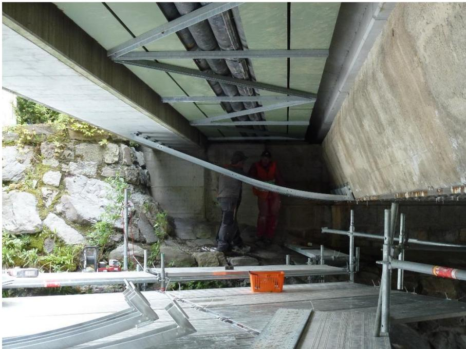
**Foto 4:** Die ersten Teile der Unterkonstruktion sind montiert (oeko-b, 17.05.2016).
