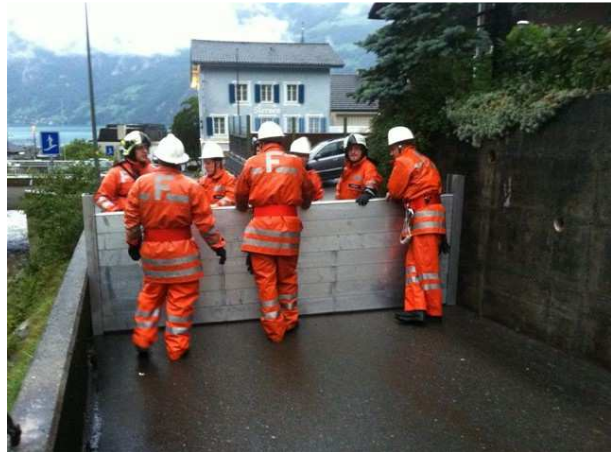
Abbildung 19: Montiertes Dammbalkenwehr am Sagenweg. Übung der Feuerwehr Sisikon zum Notfallkonzept Riemenstaldnerbach (31.08.2012).
