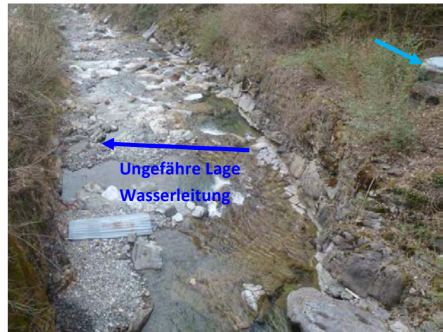
Abbildung 7: Sperrenfreier Abschnitt innerhalb der Sperrertreppe (Blick in Fließrichtung). Am rechten Bildrand ist der Sammelschacht ersichtlich (hellblauer Pfeil).
