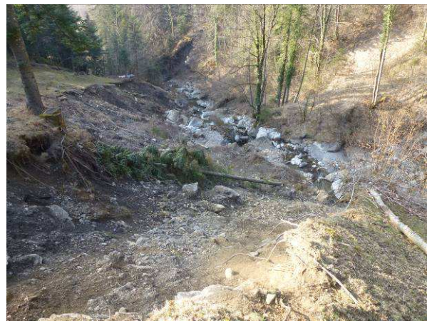
Abbildung 18: Abgerutschte und brach liegende Waldfläche bei der Rutschung Rüti.
