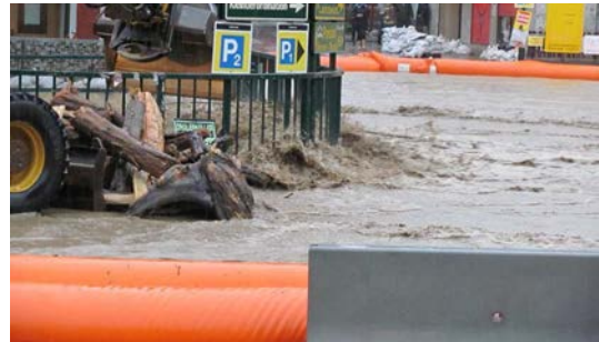
Abbildung 14: Beispiel von Beaver-Schläuchen im Einsatz (Quelle: Andreas Roos, Beaver Schutzsysteme AG).
