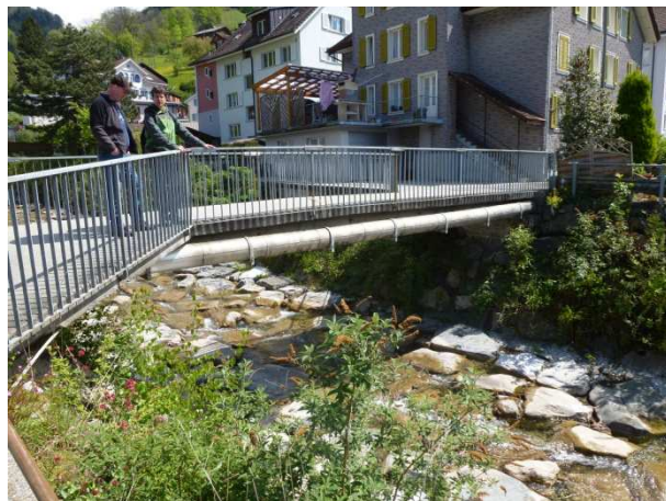
Abbildung 9: Talseitige Ansicht der Kirchenweg-Brücke. Unterhalb des Geländers ist das Rohr der Kanalisation ersichtlich.
