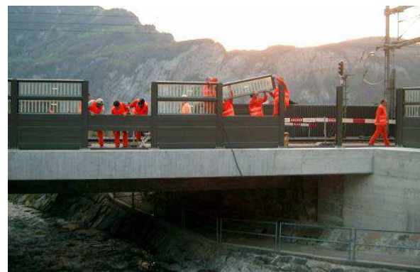
Abbildung 12: Entfernung der bergseitigen Lärmschutzwand bei der SBB-Brücke (TBA Kt. Uri, 29.04.2005).
