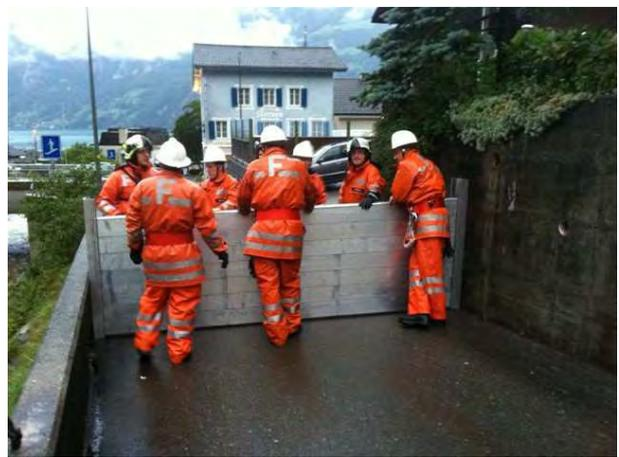
Abbildung 4: Übung zum Notfallkonzept Riemenstaldnerbach. Montage Dammbalkenwehr Sagenweg, Sisikon (31.08.2012).
