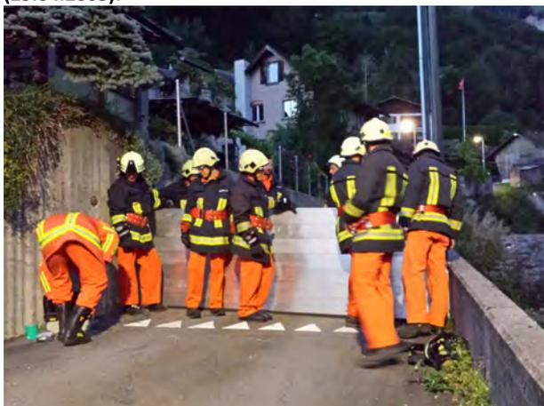
Abbildung 5: Übung zum Notfallkonzept Riemenstaldnerbach. Montage Dammbalkenwehr Sagenweg, Sisikon (07.09.2015).
