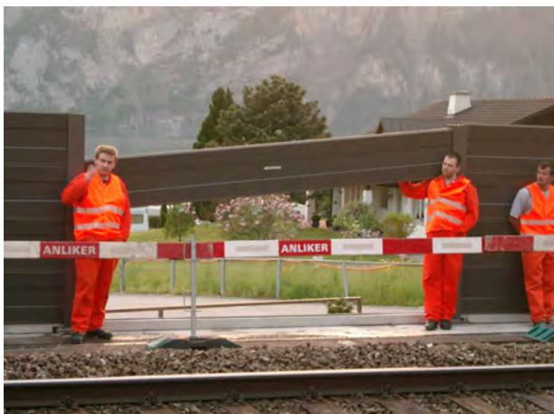
Abbildung 3: Übung zum Notfallkonzept Riemenstaldnerbach. Demontage Lärmschutzwand talseitig der Brücke SBB (29.04.2005).
