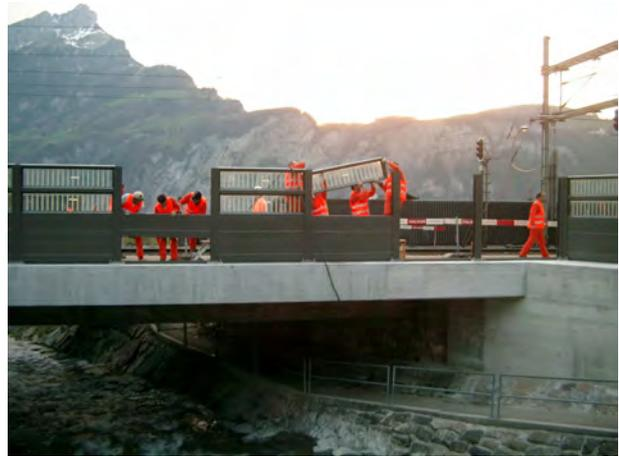
Abbildung 2: Übung zum Notfallkonzept Riemenstaldnerbach. Demontage Lärmschutzwand bergseitig der Brücke SBB (29.04.2005).
