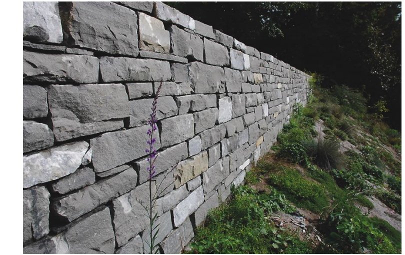
Mauer aus formwidlen Blocksteinen
