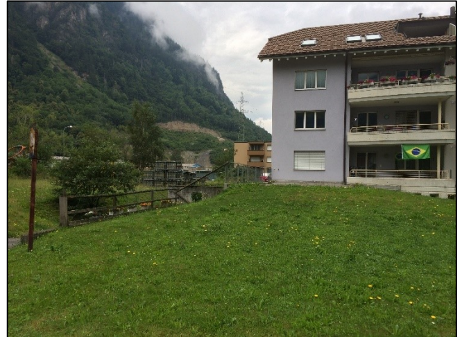
Abbildung 8: Referenz bestehendes Mehrfamilienhaus, Mai 2014, R+K
