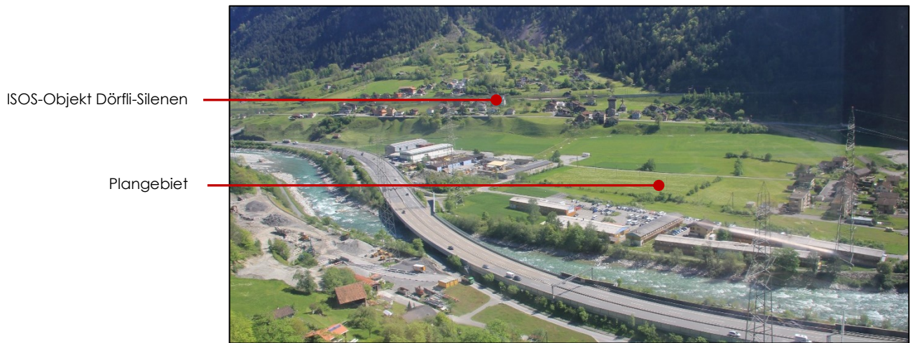
Abbildung 1: Überblick Plangebiet aus der Luftseilbahn Amsteg-Arni, Mai 2014, R+K
