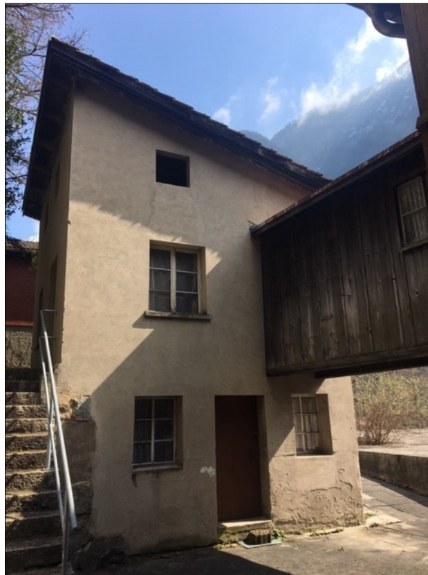
Angebaut zu Haus Nr. 8, unbenutzt, war ehemaliges Bürogebäude (Nr. 9).
