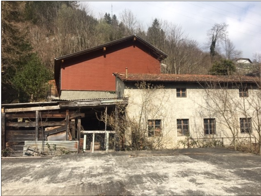
Blick von Lagerhalle auf Scheune (Nr. 10) und Schützenhaus (Nr. 12).
