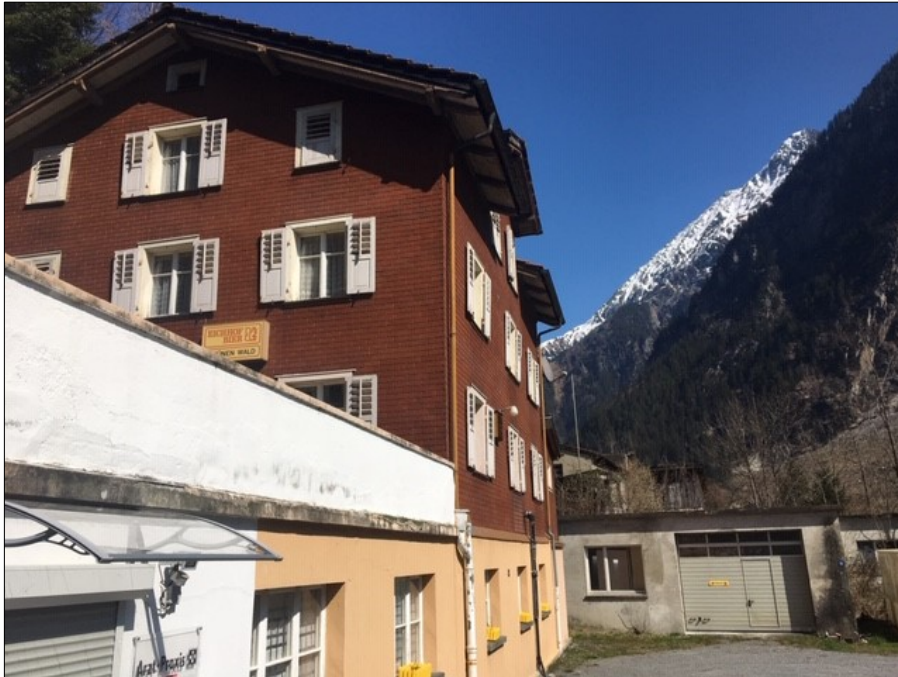
Links: Arztpraxis im unteren Bereich. Oben verlassen. Lagerhalle frontal.
