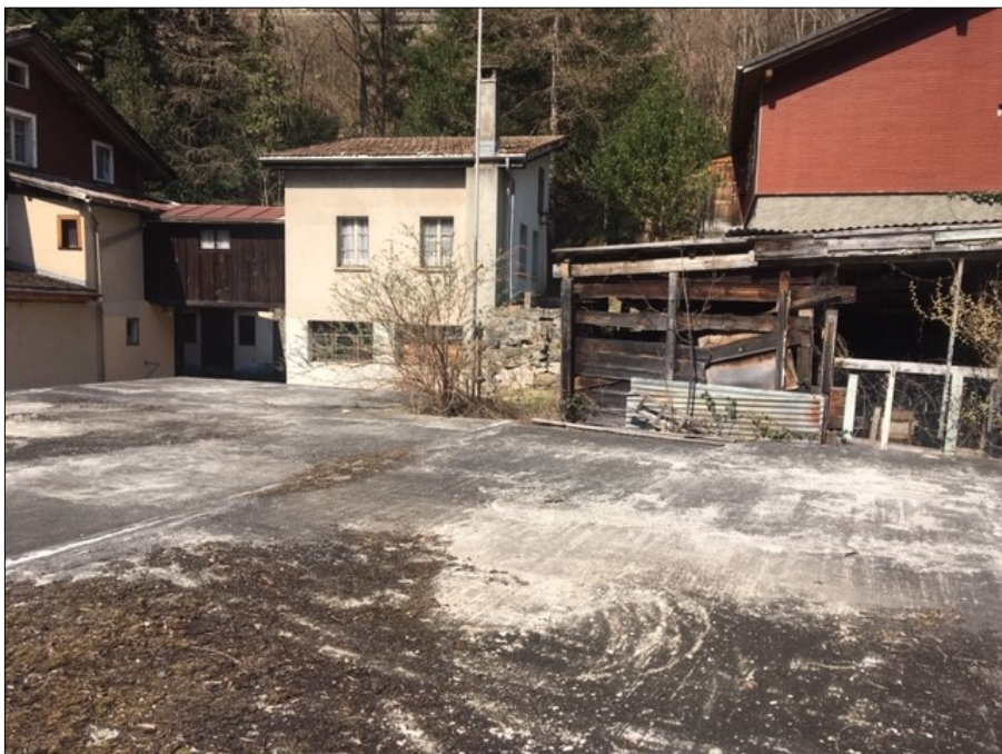
Blick auf ehemaliges Büro/Scheune und Schützenhaus.
